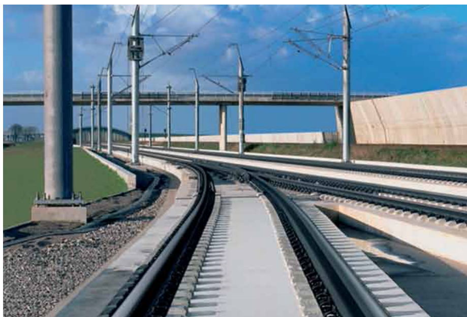
Figur 8: En anläggning med Rheda 2000® (RailOne, 2011).
