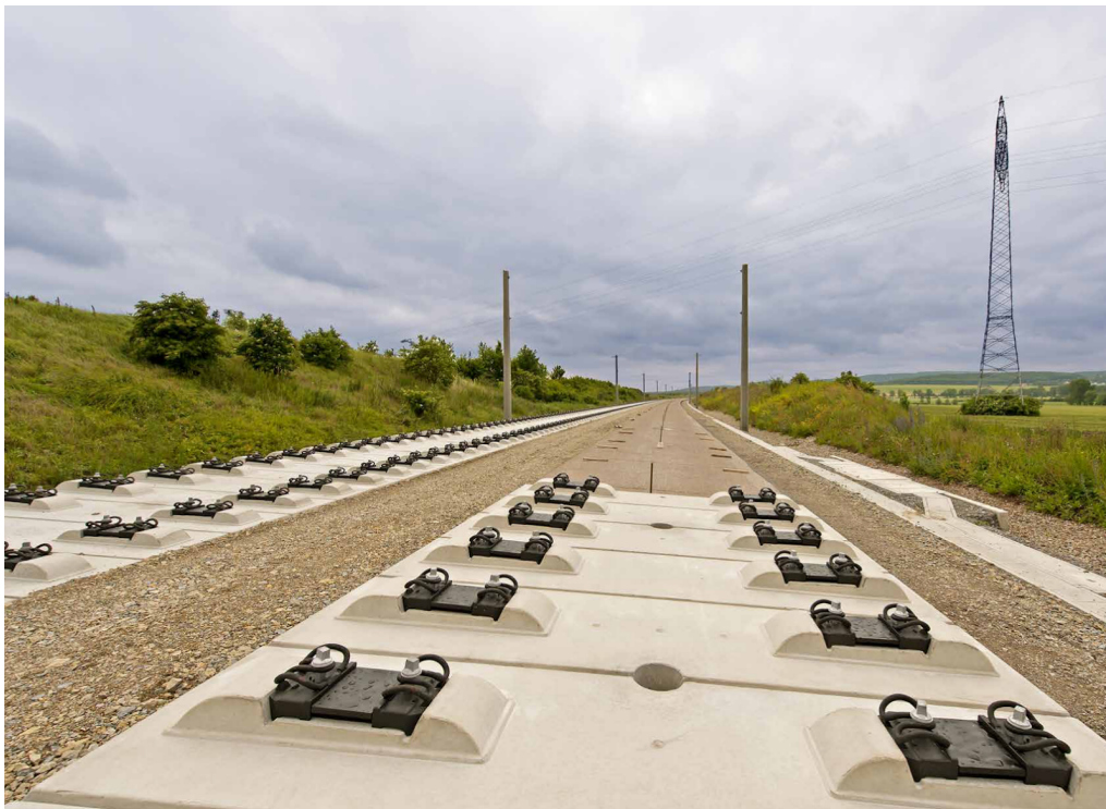
Figur 10: Bögl levereras som prefabricerade delar med förmonterade spårfästen (Tarmac-Maxboegl, 2015, 21).
