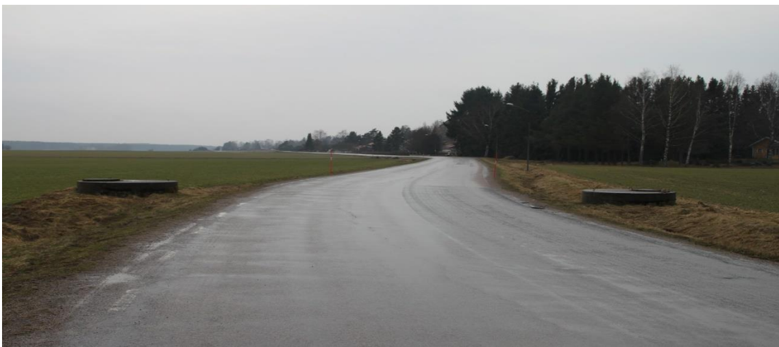
Figur 18. Exempel på vågbrunnar, situation 1 väg 678.
