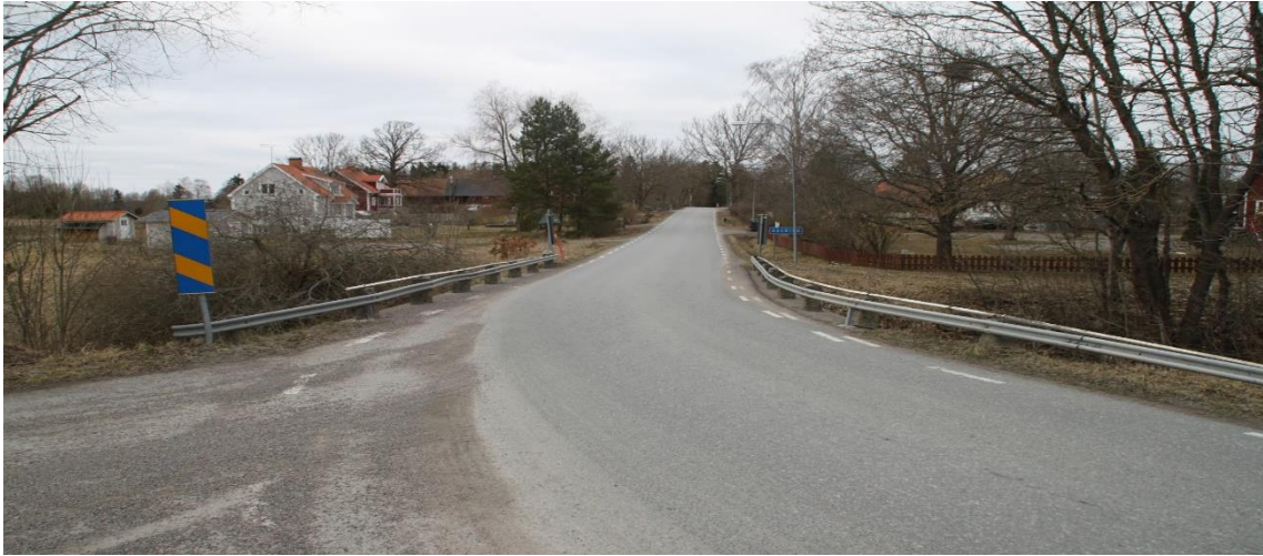
Figur 25. Exempel på broräcke som inte uppfyller nuvarande standarder, situation 9 väg 631.
