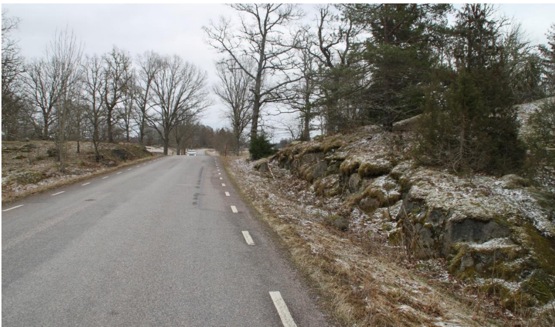
Figur 16. Exempel på klippblock i sidoområdet, situation 6 väg 631.
