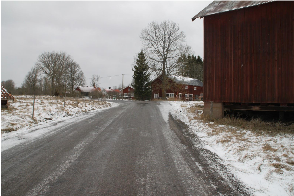
Figur 36. Exempel på hus i ett samhälle som är placerat nära vägen, situation 1 väg 1120.
