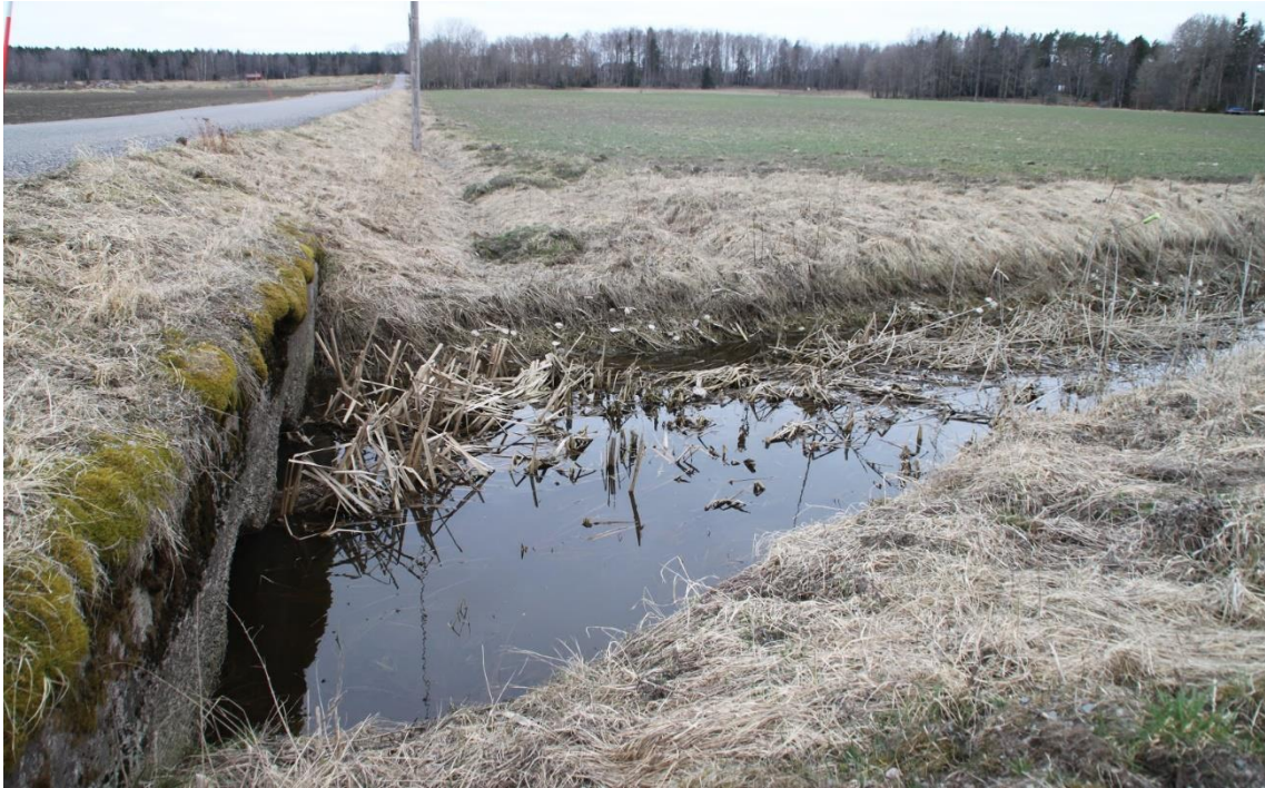
Figur 33. Exempel på vägsituation där det borde vara räcke, situation 7 väg 631.
