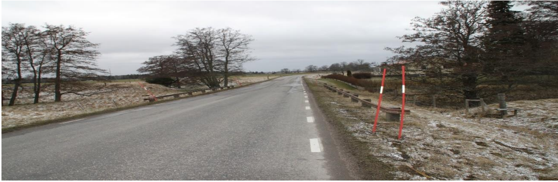
Figur 23. Exempel på vägräcke som inte uppfyller de nuvarande standarderna, situation 2 väg 631.
