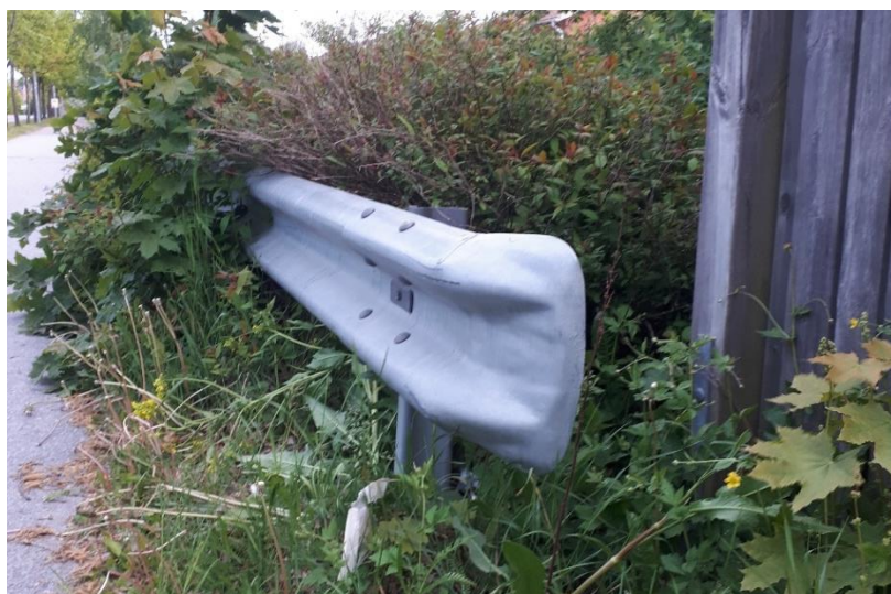
Figur 3. Exempel på ett farligt räckesavslut, en "fiskstjärta".
