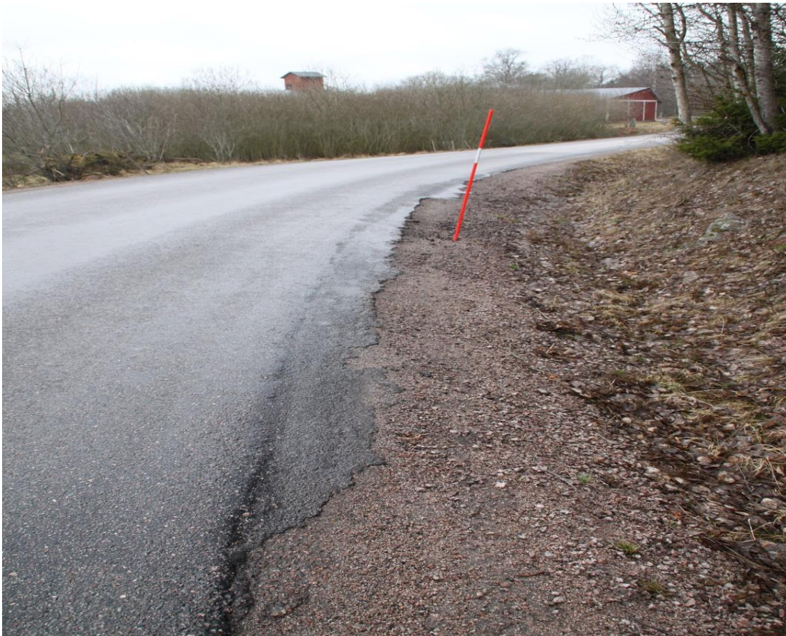
Figur 40. Exempel på trasig stödremsa i vägens innerkurva, situation 4 väg 678.
