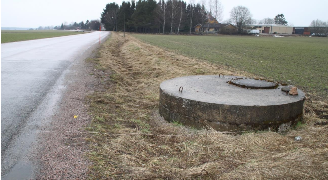
Figur 19. Exempel på vägbrunn, situation 1 väg 678.
