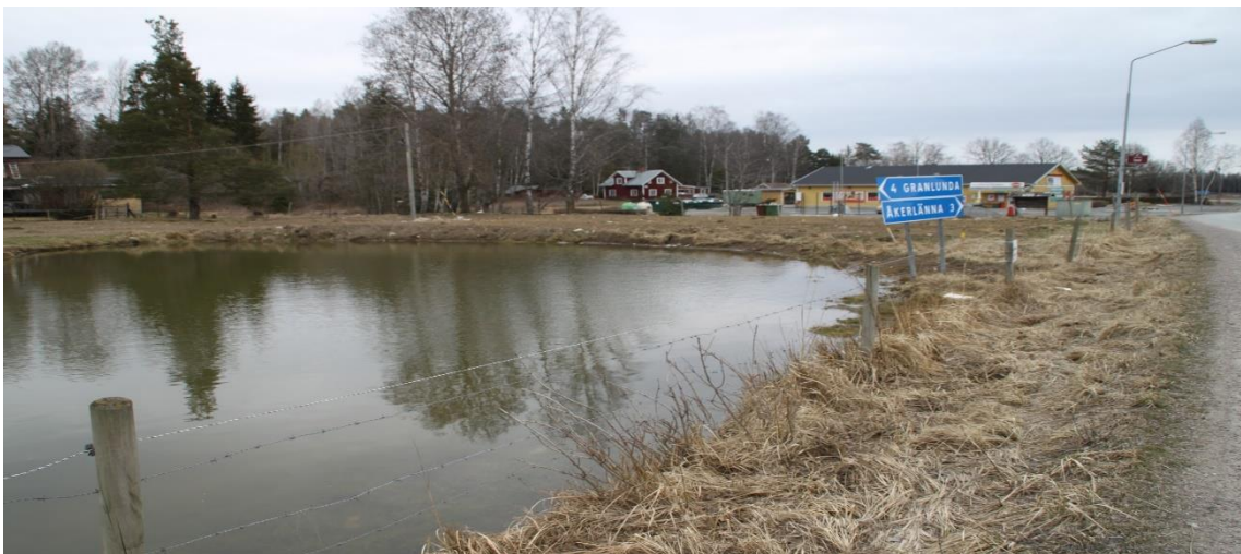
Figur 35. Exempel på farlig korsning, situation 10 väg 631.
