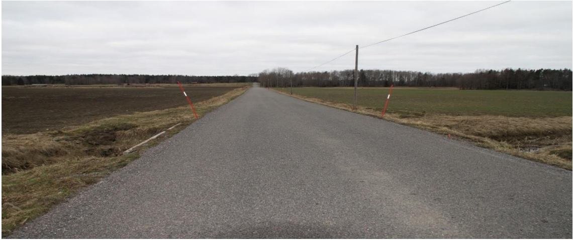
Figur 31. Exempel på vägsituation där det borde vara räcke, situation 7 väg 631.
