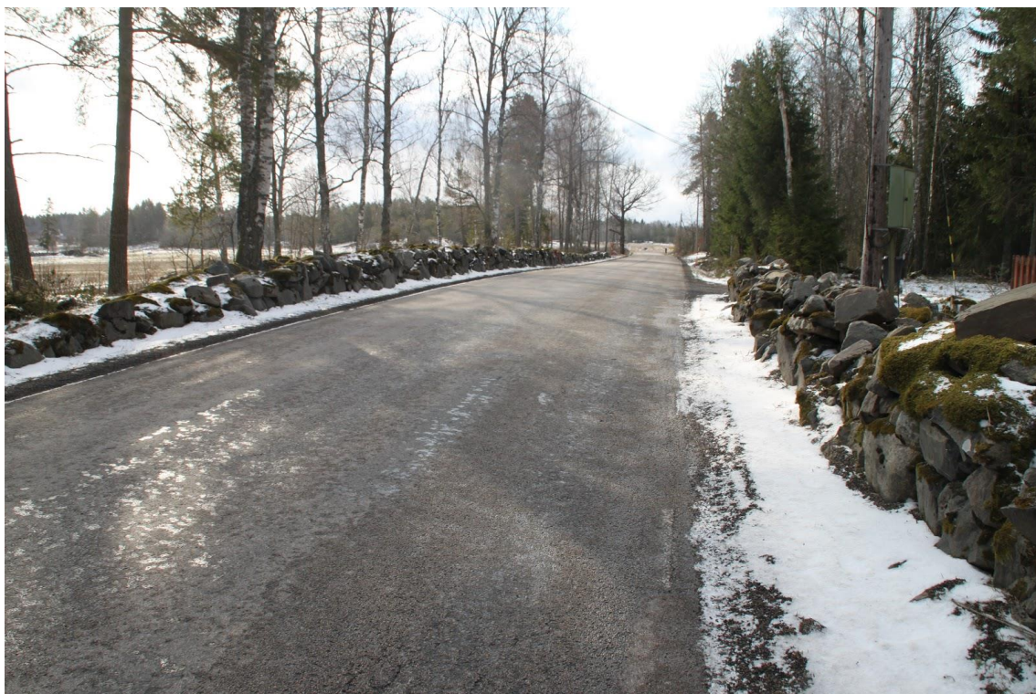
Figur 21. Exempel på stenmur längs vägen, situation 3 väg 1120.
